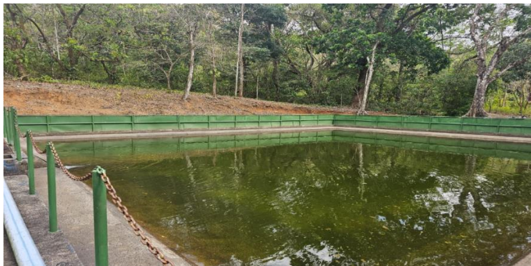
Figura No. 6 Asociaciones Administradoras de Acueductos Comunales (Asadas). Planta Potabilizadora de la Asada Pital Centeno de Orotina
